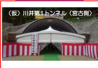
⑫施工：西松建設
