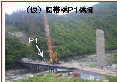
⑩施工：大豊建設
