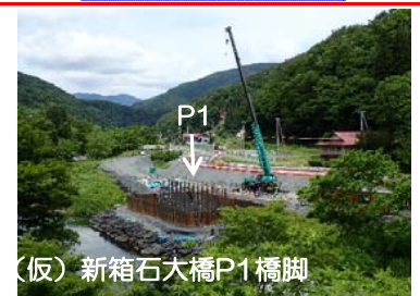
⑰施工：安藤・間
